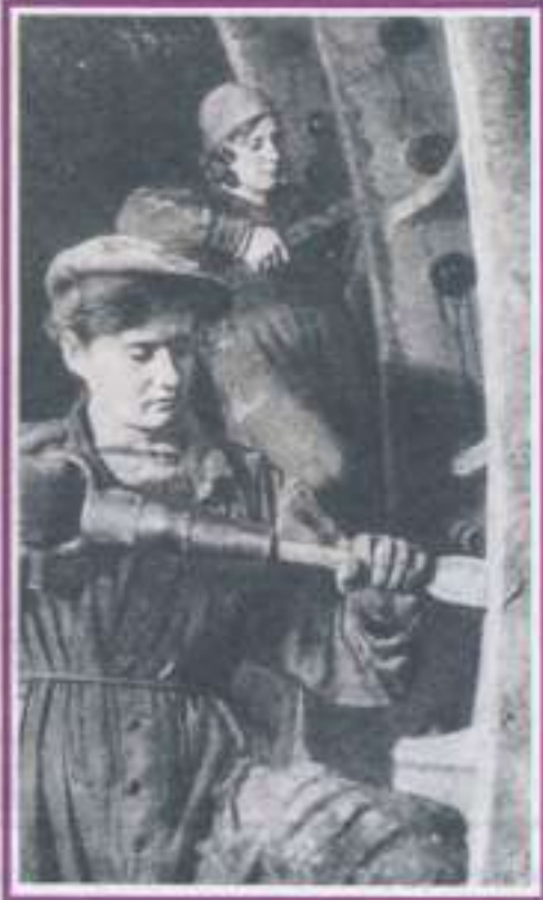
На строительстве московского метро. 1934 год
