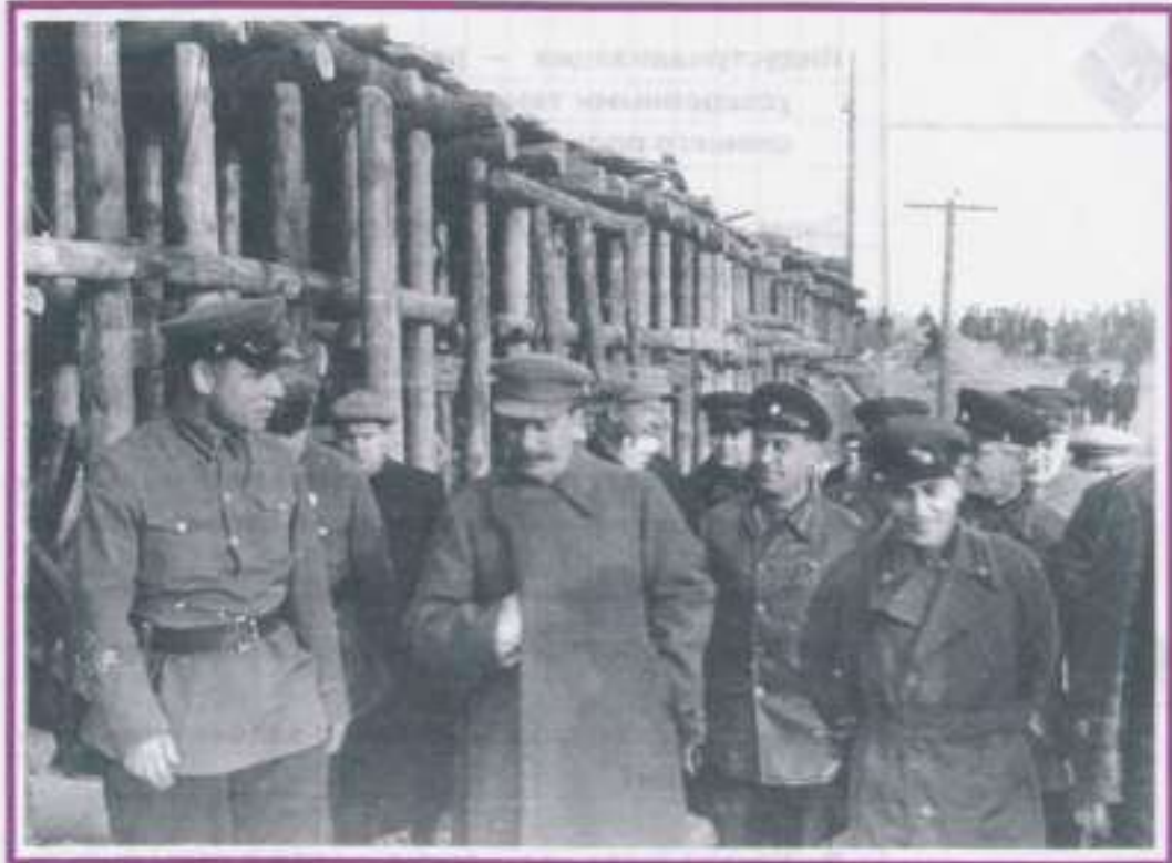
Сталин и другие партийные работники проводят инспекцию строящегося заключенными канала
