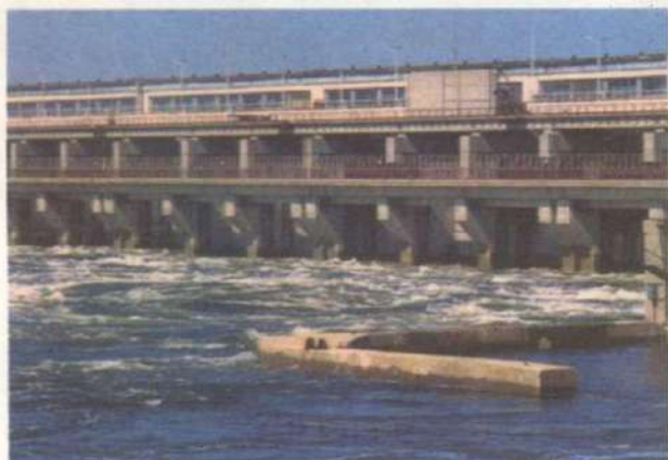
Рис. 55. ГЭС на Волге
