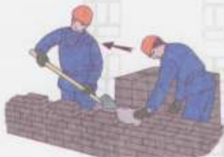
Рис. 81. Кладка стены толщиной полтора кирпича звеном «двойка»
