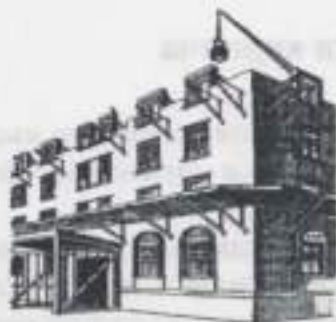
Рис. 62. Защитный козырёк на строящемся здании
