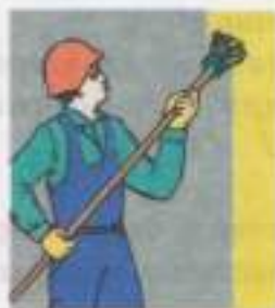
Рис. 16. Проклеивание стен клейстером
