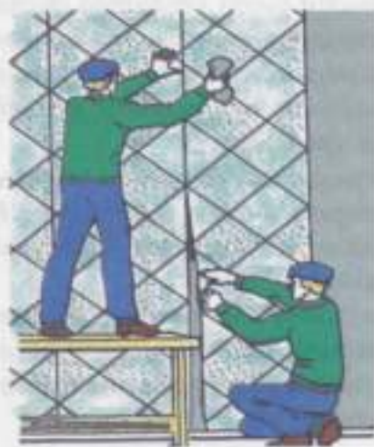
Рис. 25. Оклеивание стен обоями звеном из двух человек
