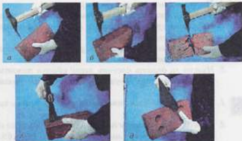
Рис. 69. Приёмы рубки кирпича:
