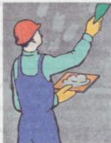
Рис. 9. Подмазка отдельных мест.
