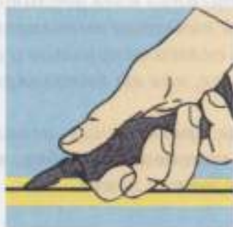
Рис. 45. Холодная сварка линолеума
