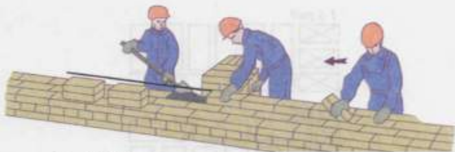
Рис. 82. Кладка стены толщиной два кирпича звеном «тройка»
