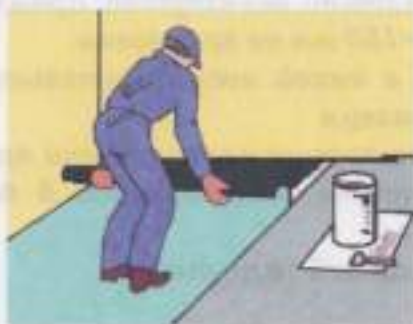
Рис. 41. Укладка половины полотнища линолеума на мастику (клей) Рис. 42. Валик для прикатки линолеума
