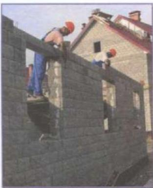
Рис. 26. Выкладка кирпичной стены
