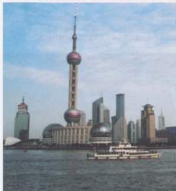
Рис. 168. Телевизионная башня в Шанхае
